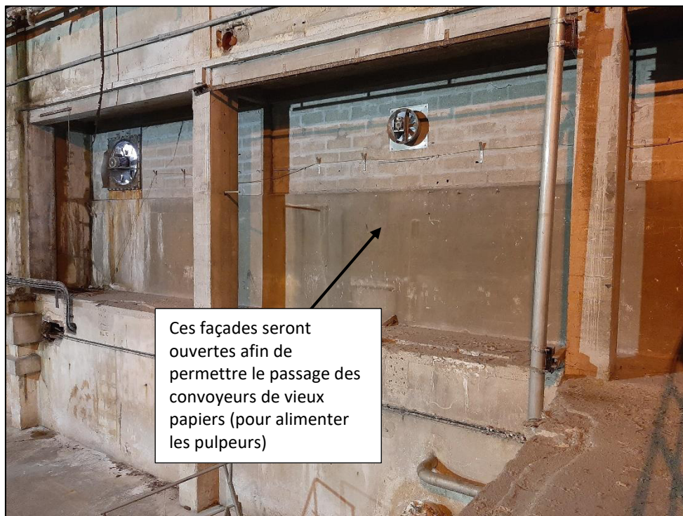
Figure 14. Facade Est du bâtiment PP1
