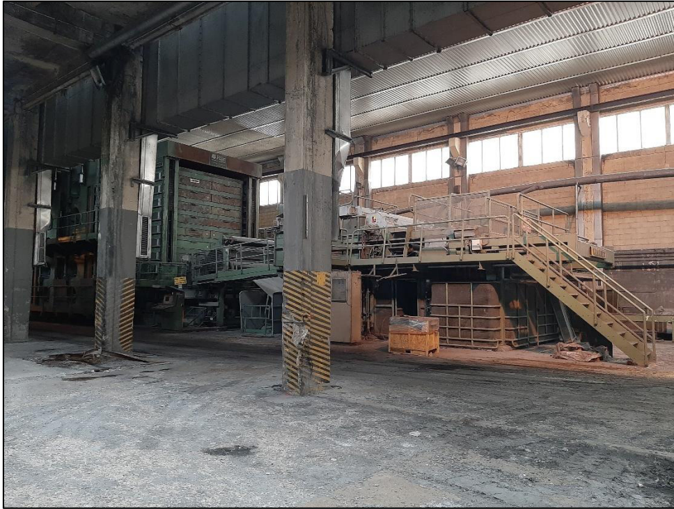
Figure 25. PP2 (partie du bâtiment existant dédié au presse-pâte)
