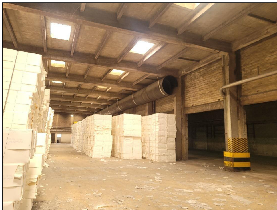
Figure 5. Bâtiment PP1 (un stockage tampon de pâte à papier et de vieux papiers y sera installé)
