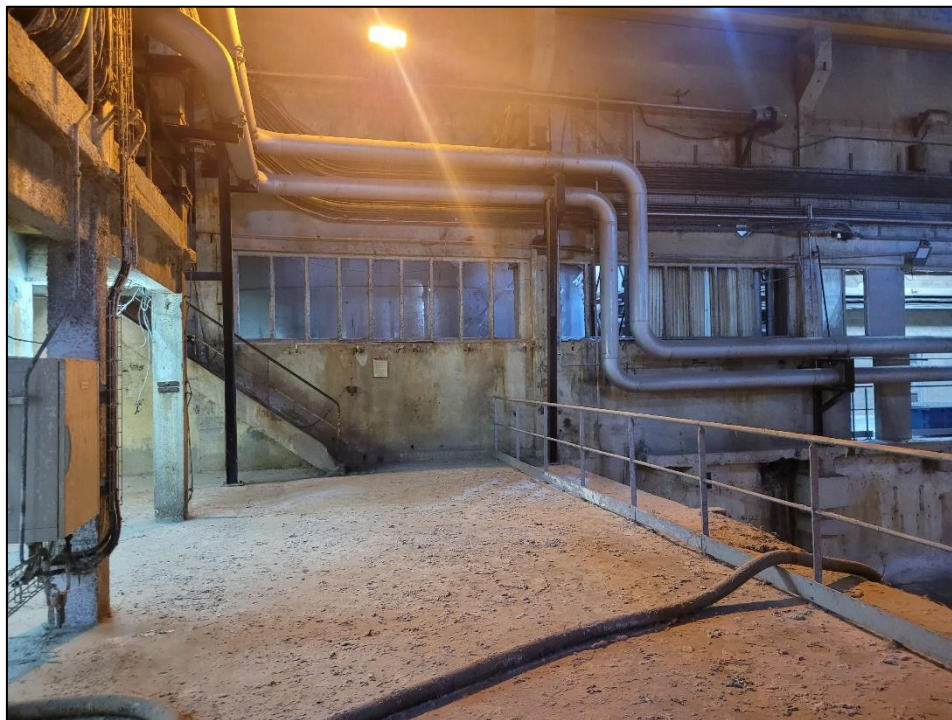
Figure 6. Local de stockage des produits chimiques (sud bâtiment PP1)
