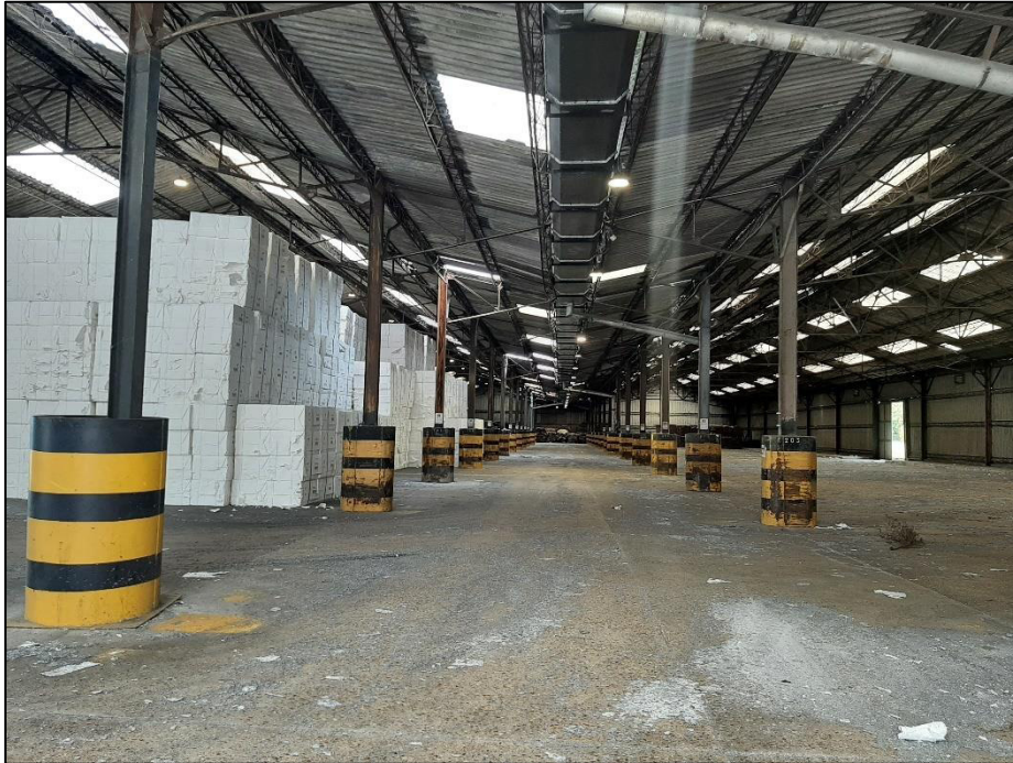
Figure 32. Intérieur du bâtiment existant SPF1 (stockage des produits finis)
